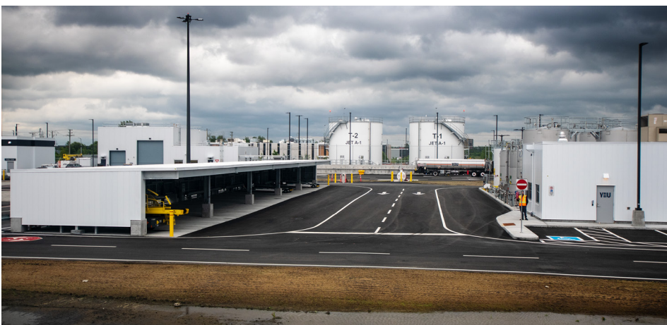
À côté de l'aérogare, il a fallu construire toute une série de structures connexes comme des abris pour les véhicules de piste et des cuves à kérosène (Jet A-1) alimentées régulièrement par des camions citernes (photo Pierre Gillard).
