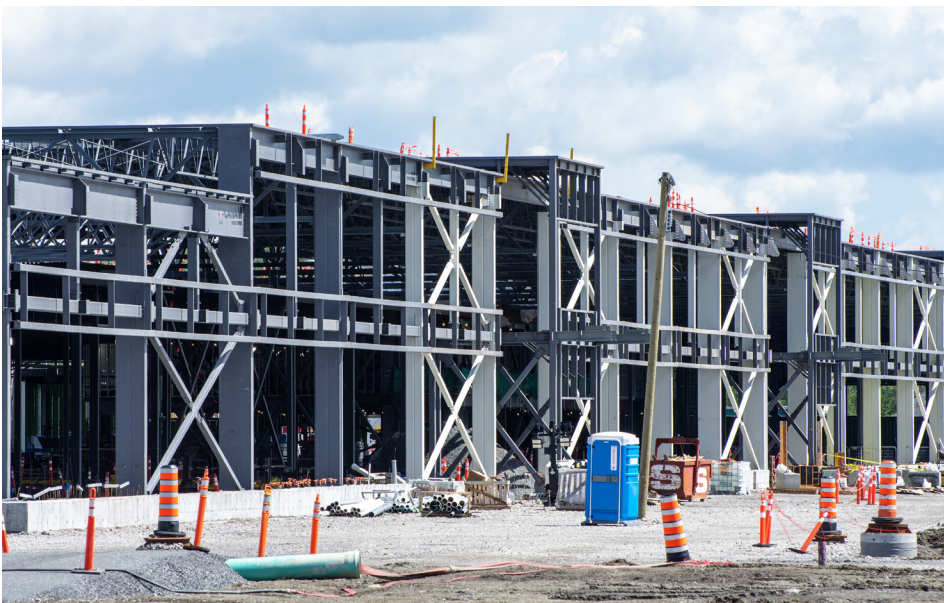
La structure de l'aérogare est en acier, très conventionnelle. À noter le peu de lumière naturelle filtrant à l'intérieur de l'édifice sur cette photo prise le 30 juin 2024 (photo Pierre Gillard).
